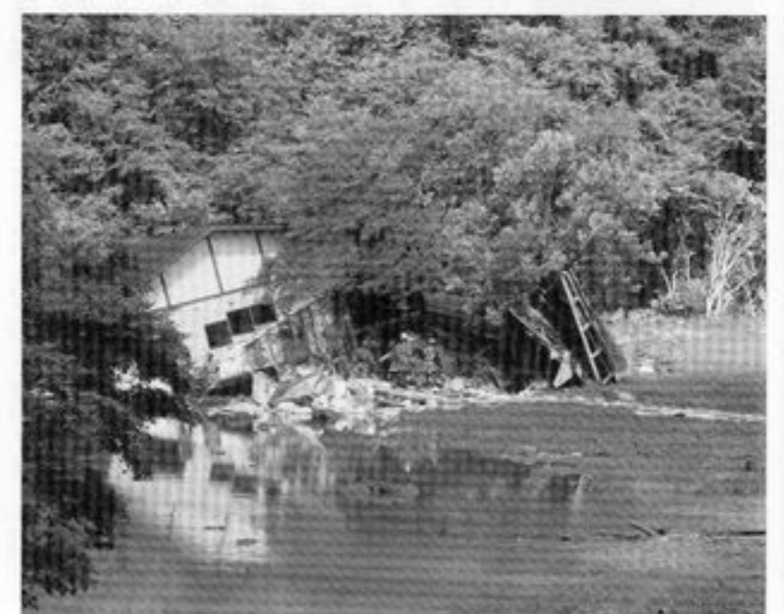
駒の湯温泉の土砂崩れ現場
