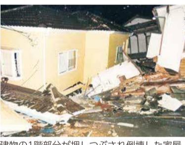
建物の1階部分が押しつぶされ倒壊した家屋
