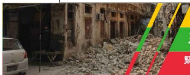
ザガインの被災状況。建物倒壊やパンケーキクラッシュが発生している。
