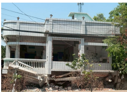
ザガインの被災状況。建物倒壊やパンケーキクラッシュが発生している。
