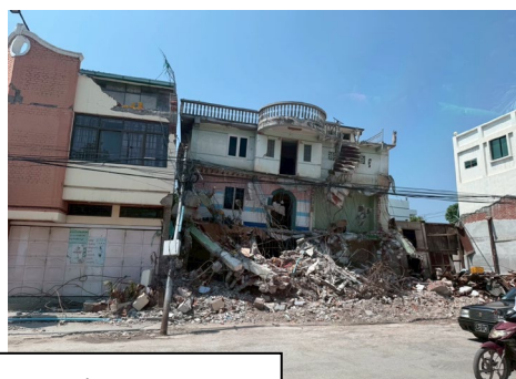
ザガインの被災状況。建物倒壊やパンケーキクラッシュが発生している。
