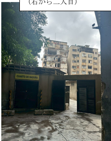
カラカス市内の被害があった 建物の様子
