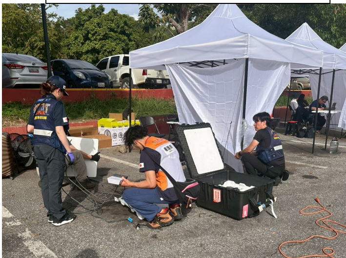
テントやインフラ設備を設営する
